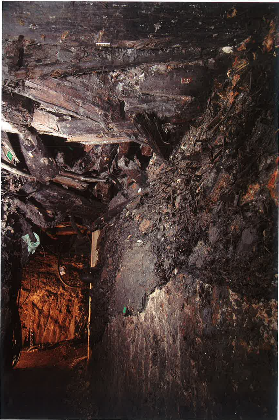
Abb. 1. Blick auf die Hölzer der verstürzten Schachteinbauten von unten (Foto: A. Rausch, NHM Wien).
