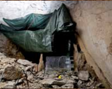
Mit Planen wird Wasser aufgefangen und in einem Messwehr werden Durchflussmenge, Temperatur und die elektrische Leitfähigkeit gemessen.
