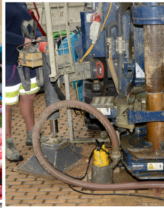
Geothermie-Probebohrung im 1. Hof des NHM
