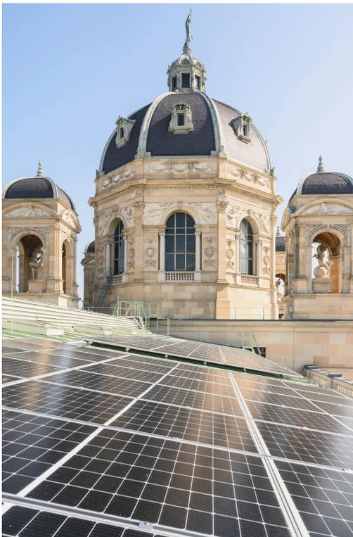
Abbildung 12: Photovoltaik-Anlage am Dach;
